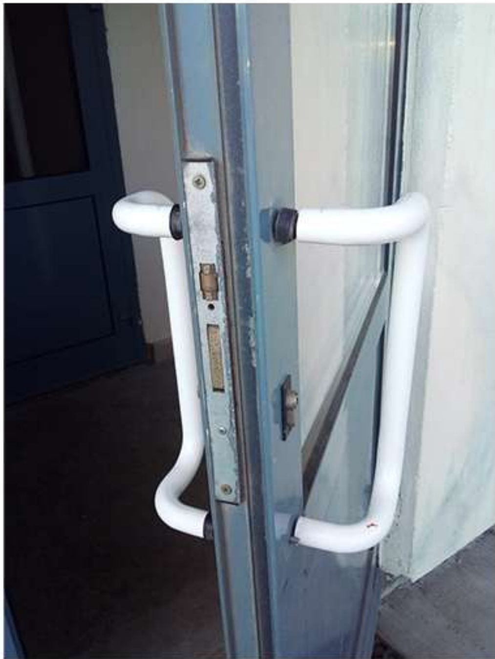
15-03. Кутузовская 33 (3й подъезд; пожарный выход). Замена дверной ручки.
